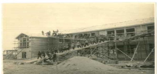
校舎の屋根に瓦を運んでいる様子
